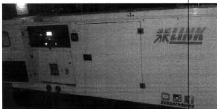
Figura 17: Colocação de um novo gerador
