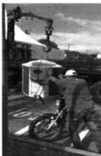
Figura 12: Colocação das condensadoras de ar condicionado no telhado
