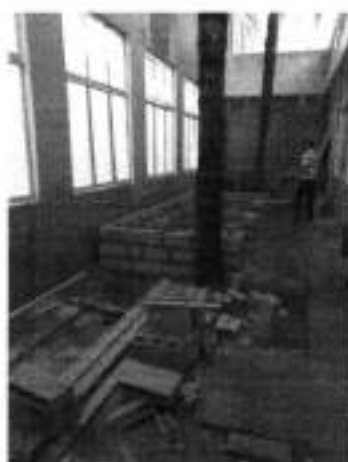
Figura 11: Execução da cabine de cilindros da UTI
