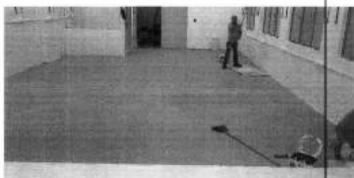
Figura 15: Pintura das paredes da UTI
