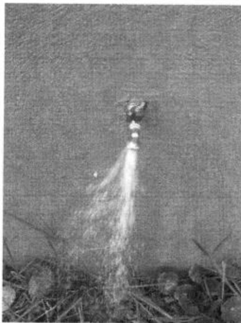
Figura 19: Instalação de torneira na base da SAMU de Vista Linda.
