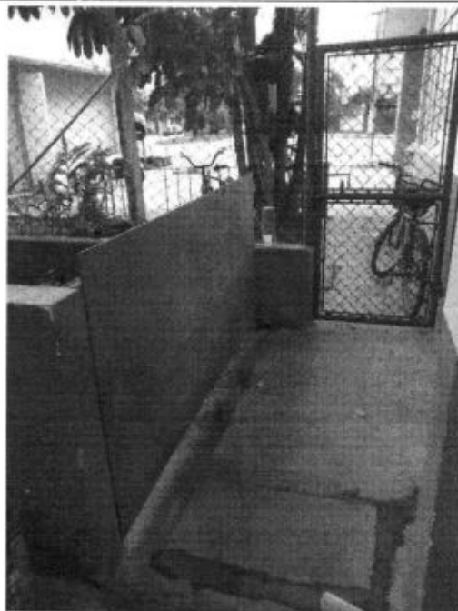
Figura 15: Instalação de divisória na área externa ao laboratório.
