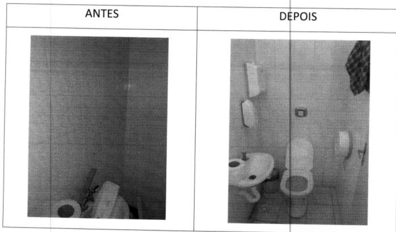
Figura 7: Instalação de suportes no sanitário.
